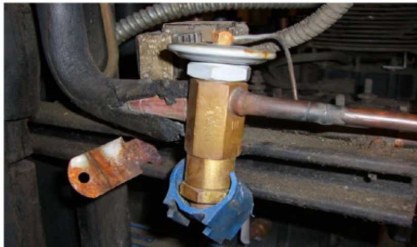
Figura 172 - Imagem de braçadeira quebrada por causa de vibrações
