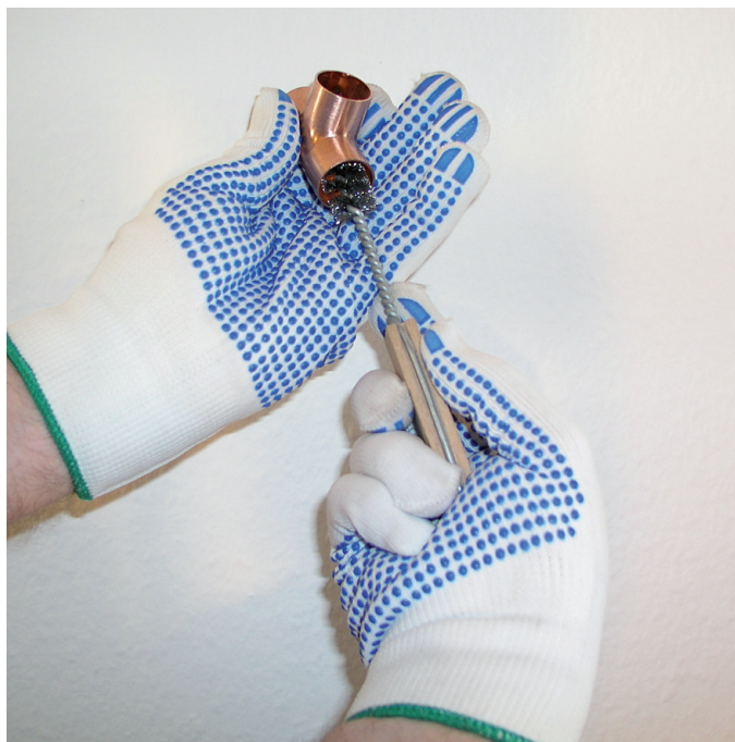
Figura 71 - Limpeza na montagem
