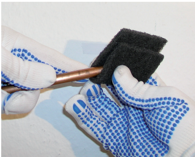
Figura 55 - Limpeza do tubo
