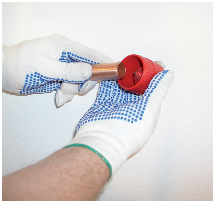
Figura 69 - Remoção das rebarbas internas
