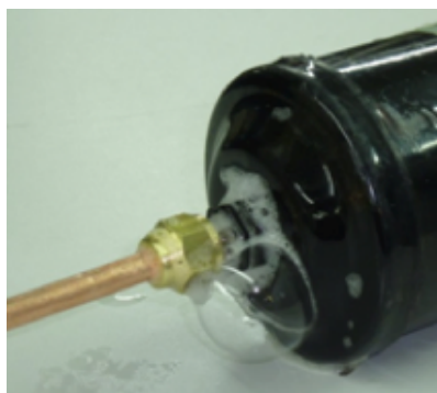
Figura 164 - Teste de vazamento com espuma de sabão
