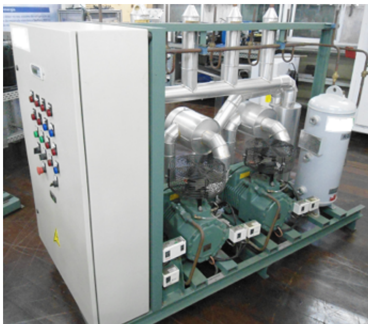
Figura 91 - Exemplo de um sistema rack
