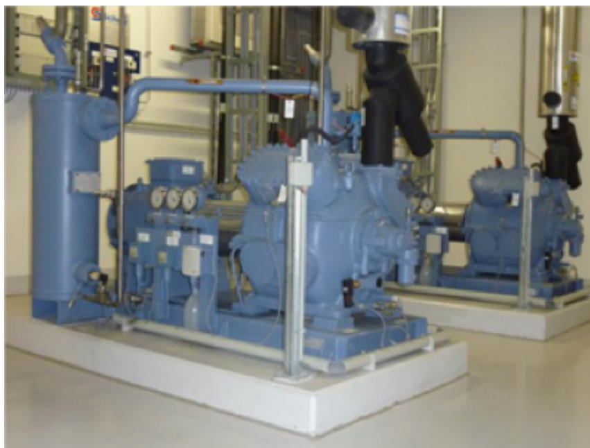
Figura 124 - Exemplo de sala de máquinas limpa
