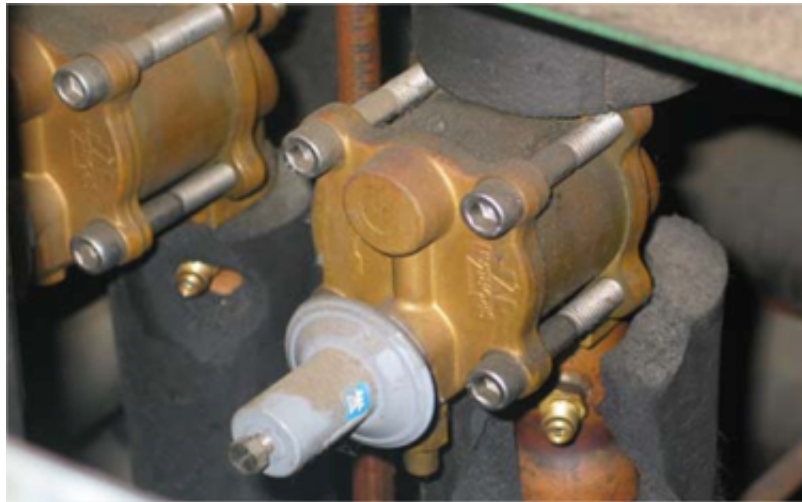
Figura 171 - Válvula Schrader sem tampa
