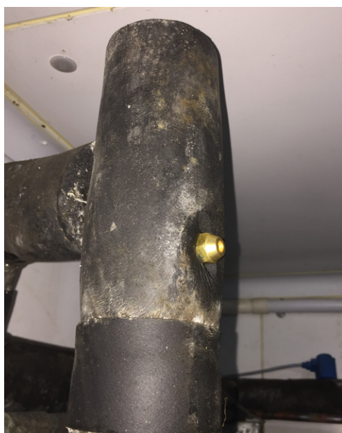
Figura 27 – Válvula Schrader na válvula reguladora de pressão KVP do evaporador da câmara de hortifrúti nº 1, com porca sextavada e selo de vedação de cobre
