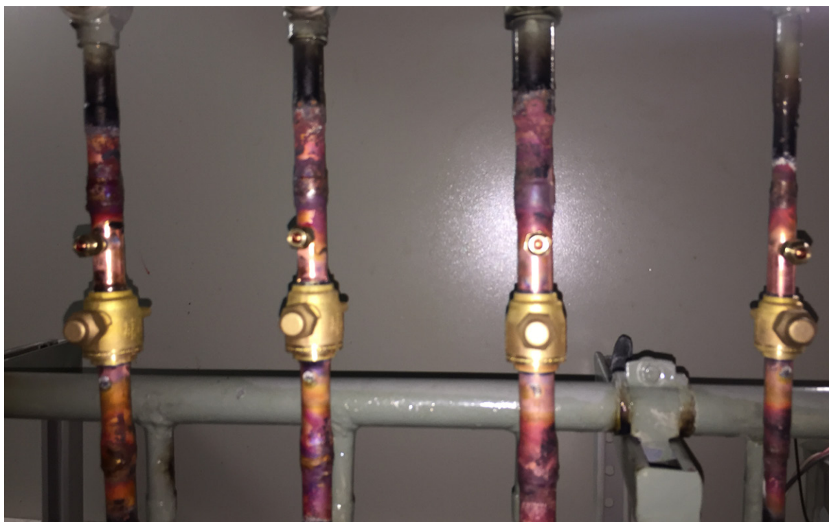
Figura 28 – Novas válvulas de serviço tipo esfera no coletor de líquido
