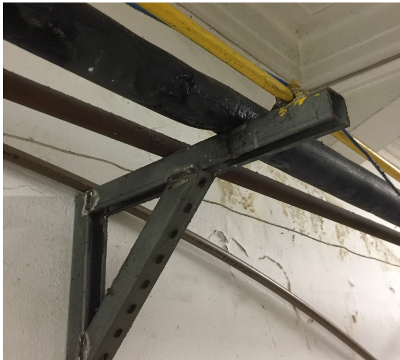
Figura 16 – Exemplo de deficiências de fixação nos suportes de sustentação
