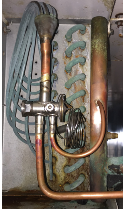
Figura 23 – Válvula de expansão com conexões para brasagem, modelo TUA , da Danfoss , no evaporador da câmara de hortifrúti nº 1
