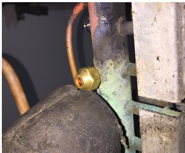
Figura 26 – Válvula Schrader no coletor de sucção do evaporador da câmara de hortifrúti nº 2, com porca sextavada e selo de vedação de cobre
