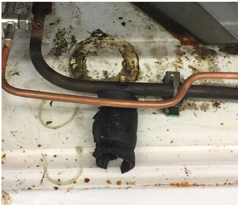
Figura 14 – Válvula Schrader instalada diretamente na tubulação sem tamponamento
