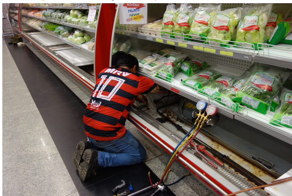
Figura 20 – Intervenção em evaporadoras na área de vendas
