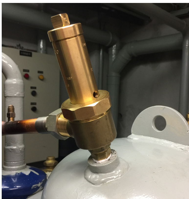
Figura 32 – Detalhe da nova válvula de segurança, com dimensionamento correto, no recipiente de líquido com tubo de saída para o coletor de baixa pressão do rack
