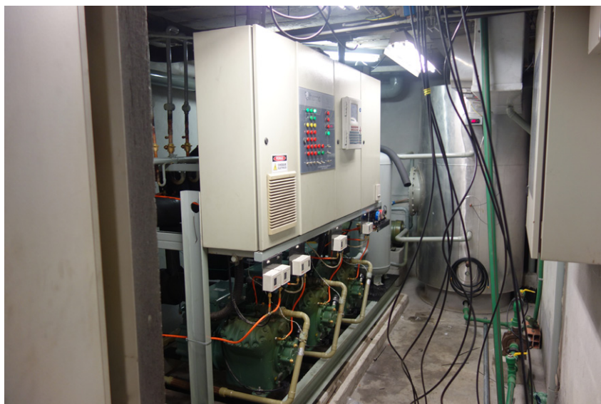
Figura 36 – Casa de máquinas após a intervenção e ficha técnica fixada
