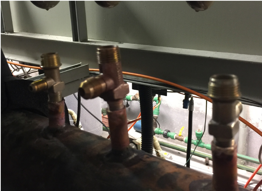
Figura 29 – Novas válvulas de serviço tipo tanque no coletor de sucção
