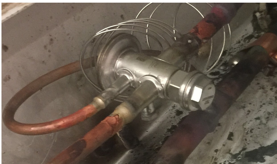
Figura 22 – Válvula de expansão com conexões para brasagem, modelo TUA , da Danfoss , no expositor de hortifrúti Linha 3R1
