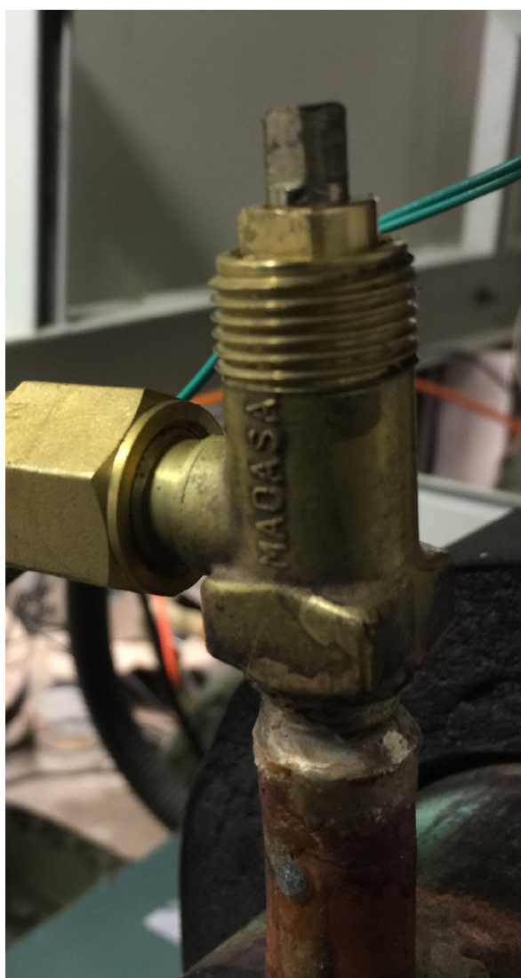
Figura 17 – Válvula tipo “tanque” instalada no coletor de sucção do rack com vazamento
