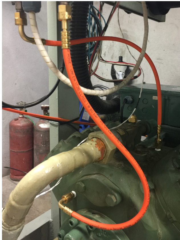
Figura 30 – Novas mangueiras de tomada de pressão nos compressores
