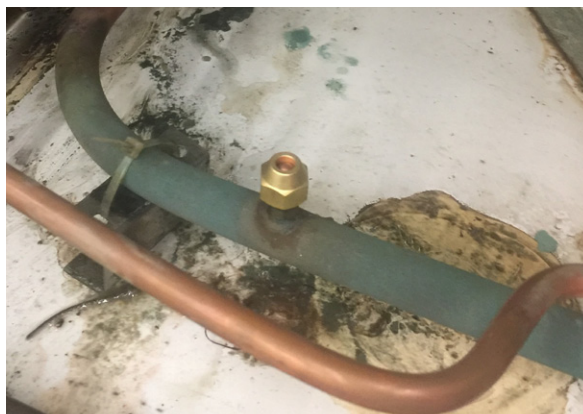
Figura 25 – Válvula Schrader no tubo de sucção do expositor de hortifrúti da linha 3R1, com porca sextavada e selo de vedação de cobre
