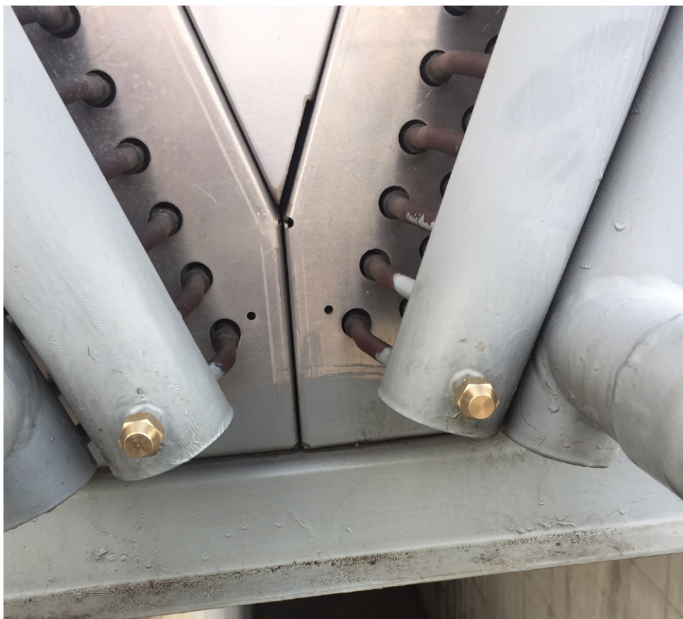
Figura 33 – Válvulas Schrader para tomada de pressão no condensador com porca sextavada cega
