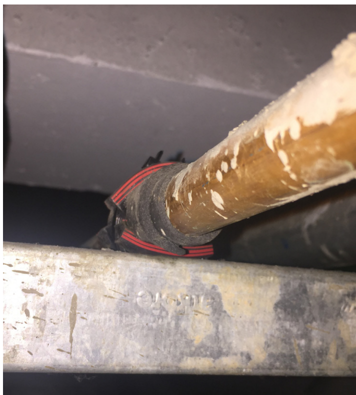
Figura 34 – Tubo de cobre da linha de líquido com apoio adequado em suporte
