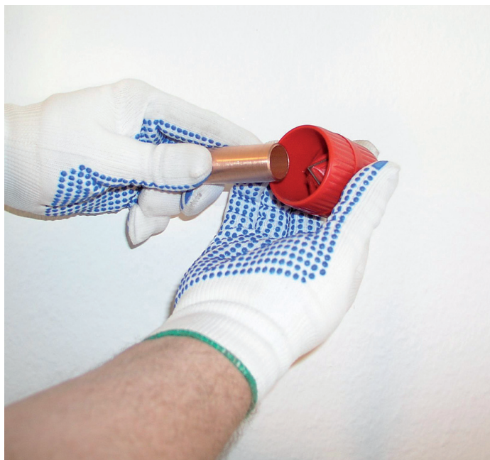
Figura 84 - Remoção das rebarbas internas
