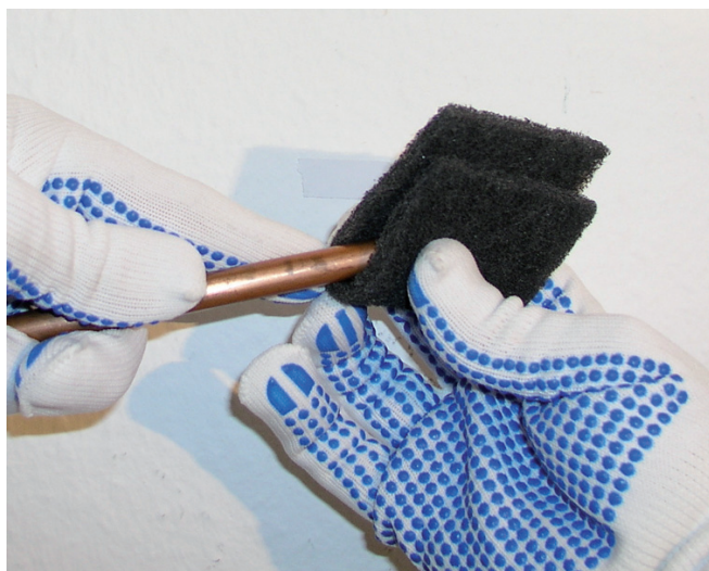
Figura 70 - Limpeza do tubo
