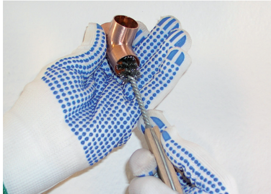
Figura 86 - Limpeza na montagem
