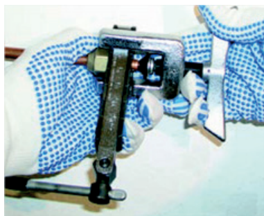
Figura 5.34 - Fixando tubo e flangeador na base.
