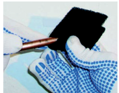
Figura 5.32 - Limpeza do tubo.
