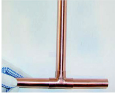
Figura 5.49 - Montagem do conjunto a ser abrasado.
