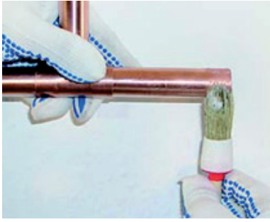
Figura 5.53 - Aplicação de fluxo.
