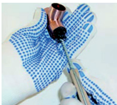
Figura 5.48 - Limpeza na montagem.
