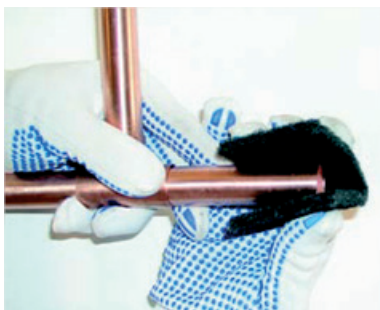
Figura 5.47 - Limpeza do tubo.
